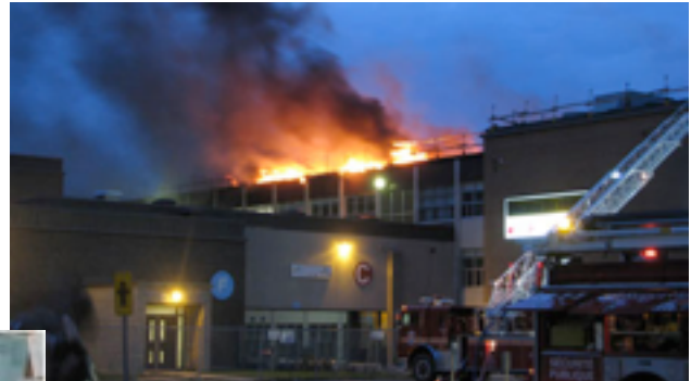
Incendie au Centre La Croisée en 2011.
